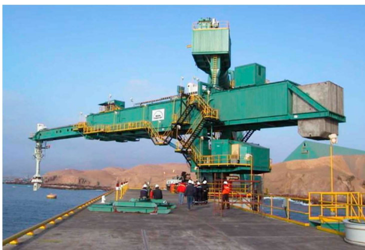
Figure 21 – Manœuvre, levage et navette de concentré de cuivre au Pérou (Source de l'image : https://pdf.directindustry.com/pdf/takraf/ship-loader-puerto-huarmey-antamina-peru/58547-538427.html )
