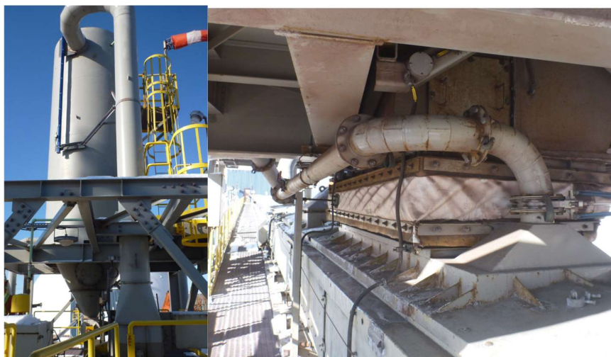
Figure 8 - 60-DC-07 en bon état (image de gauche). Point de transbordement propre (image de droite).
