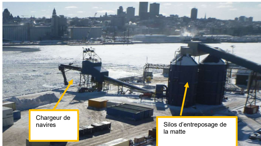
Figure 4 – Silos d'entreposage de la matre et chargeur de navires
