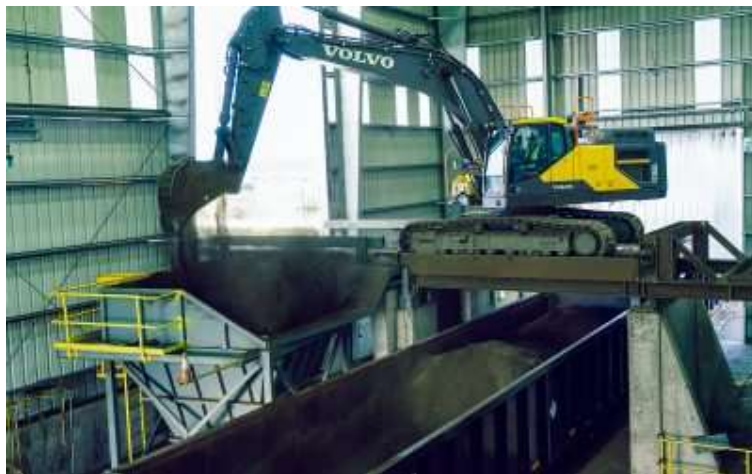
Figure 19 – Déchargement de wagons à l'aide d'une excavatrice
